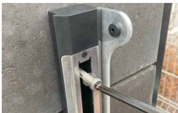
Bild 7. Bult till betongankare.
