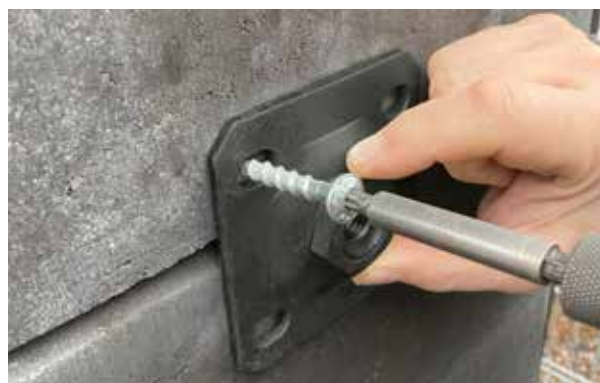
Bild 4. Gängjärnsplattans betongskruv.
