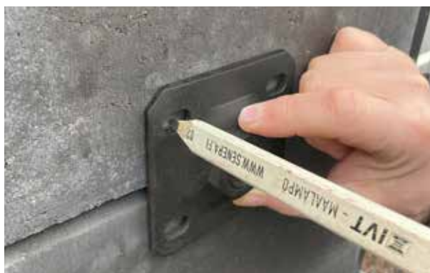
Bild 3. Smidesgrindens gängjärnsplatta.
