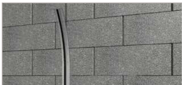
2. Montera Webertherm 421 eller liknande difogslist över snittet. Putsa sedan mot listen.
