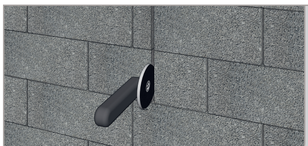
1. Säg ett snitt i väggen med en stenklinga för att bestämma var eventuella sprickor ska hamna.
