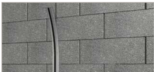
2. Montera Webertherm 421 eller liknande diffogslip över snittet. Putsa sedan mot listen.
