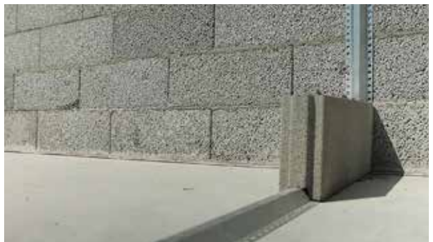
BILD 4. Vägprofilen förenklar arbetet och förankringen till anslutande väggar. Den kan också användas över mindre öppningar.
