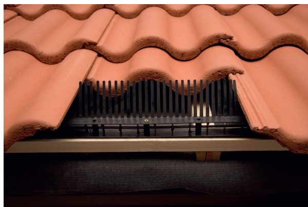
Montering av ventilerat fågelband
