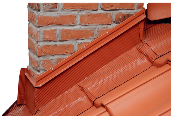
Montering av skorstenstätning
