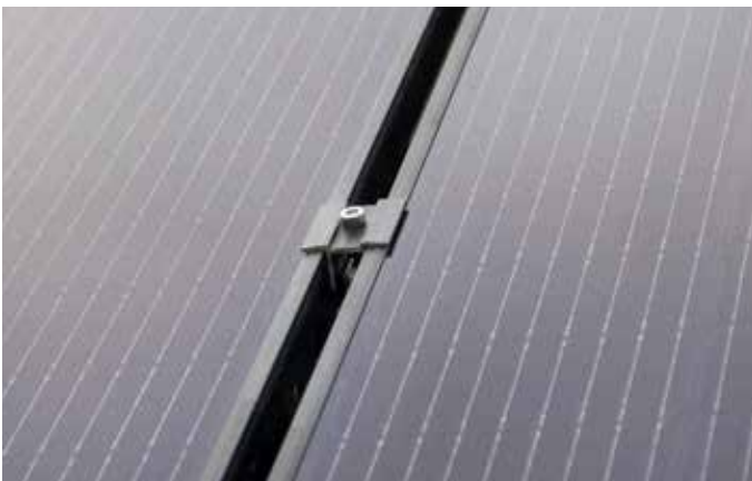
Bild 8. Mittklämma monterad.
