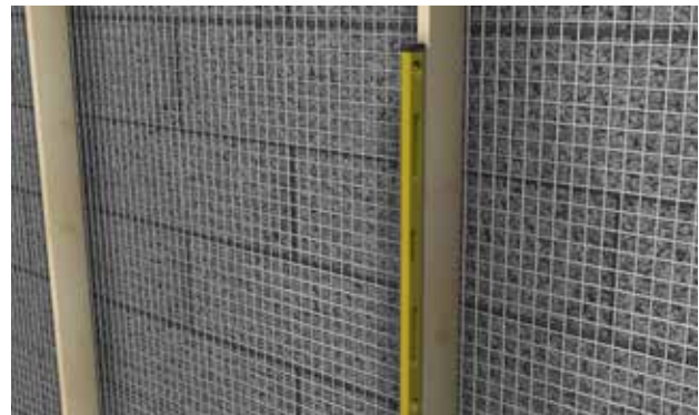
Bild 4.2 Montage av putsläkt
