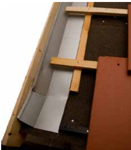
11a pav. Vandens patenkančio po universaliomis čerpėmis nuvedimui į lietaus sistemą(lataką), naudokite plieninius lankstinius.
