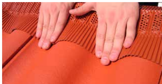
14 pav. Benders kraigo ventiliacinė tarpinė montuojama ant medinio kraigo tašelio prikaland ją vinutėmis arba „prišaudant“ kabėmis. Nuimkite apsauginę plėvelę, esančią kitoje (apatinėje) kraigo tarpinės pusėje ir gerai prispauskite kraštus prie čerpių paviršiaus. Oro temperatūra turėtų būti ne žemesnė negu +5°C, o čerpių paviršius, ant kurio klijuojama tarpinė, švarus ir sausas.
