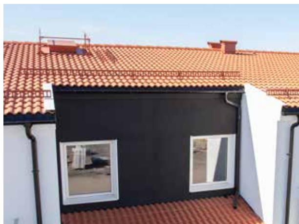
30b pav. Sumontuokite sniego užtvaras virš ventiliacinių kaminėlių ir kitų elementų, kad apsogotumėt juos nuo pažeidimų dėl slenkančio sniego ar ledo.
