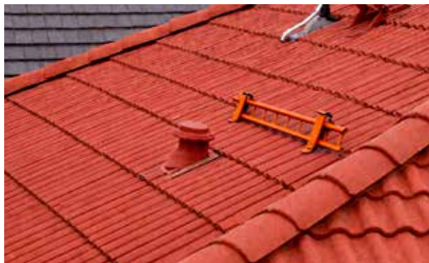
30b pav. Sumontuokite sniego užtvaras virš ventiliacinių kaminėlių ir kitų elementų, kad apsogotumėt juos nuo pažeidimų dėl slenkančio sniego ar ledo.
