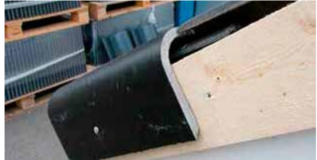
8 pav. Nupjaukite šoninės čerpės viršutinę siauresnę dalį
