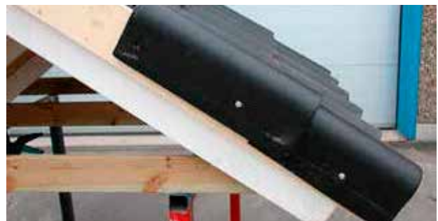
11b pav. Tvirtinant šonines universalias čerpes, pirmiausiai pragręžkite jose tvirtinimui numatytas skyles iki galo.
